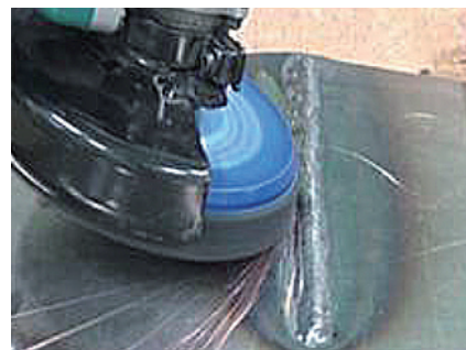
Rmover decoloración de la soldadura
